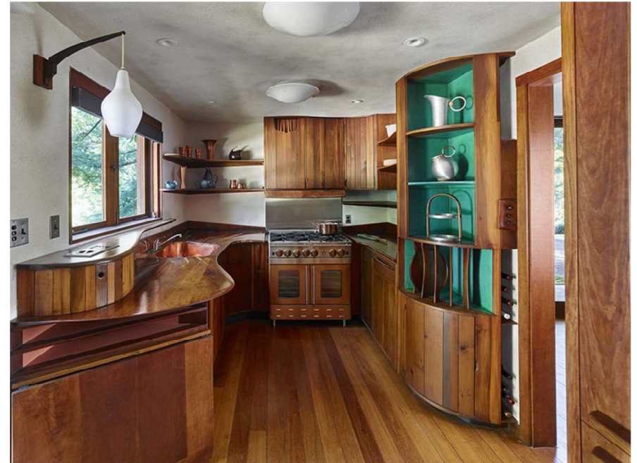
Şekil:2 (Mutfak)Restorasyon sonucu orijinal olmayan aydınlatma birimleri, lavabo ve dolap içi boyamalar.
