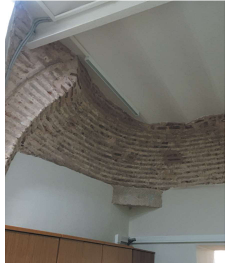
Darüşşifa binasının kesilen kubbeleri ile volta döşeme birleşimi
