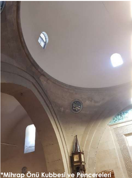
*Mihrap Önü Kubbesi ve Pencereleri
