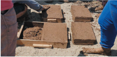
Kerpiç harcın kalıplanması
