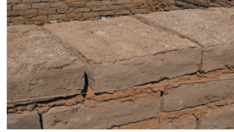
Kerpiç duvarlarda derz şaşırtması
